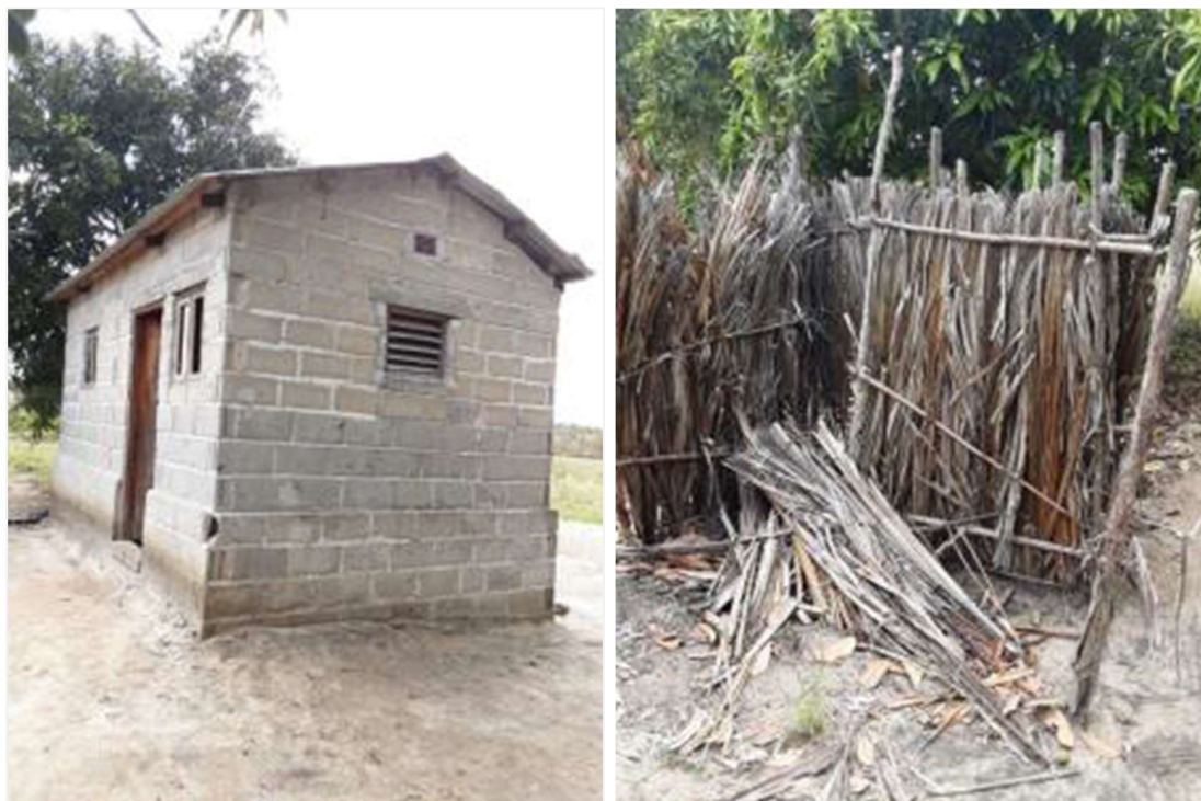
Figura 24: Estruturas registadas pelo AF0210 (abrigo à direita e latrina à esquerda)
