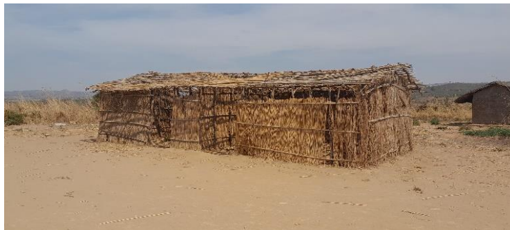
Fig.21: Sala anexa do EP1 no Povoado de Temba
