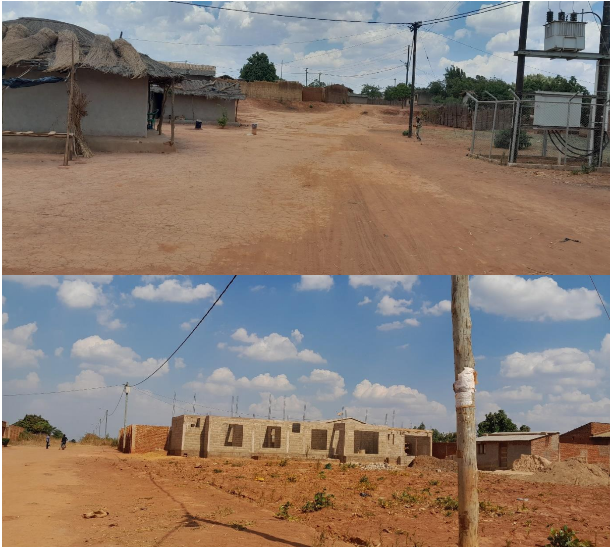
Figura 61: Imagens da rede de energia nos bairros de Lulimile e Nomba, Cidade de Lichinga mostrando posto de transformação da EDM em unidades comunais com casas de vários tipos (em cima) e uma zona de expansão no Bairro de Nomba
