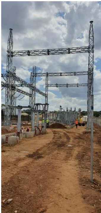
Fig. 3: Subestação em construção
