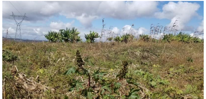
Fig.18: Bananeiras na Servidão da Linha de Energia, no Bairro de Lulimile
